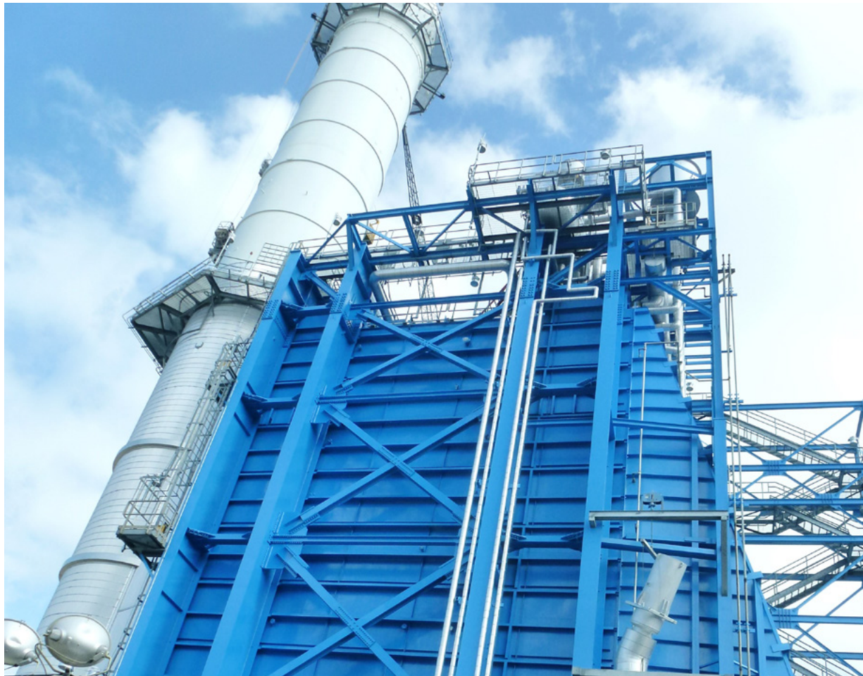
DrumPlus HRSG at El Segundo Power Plant, California, USA
